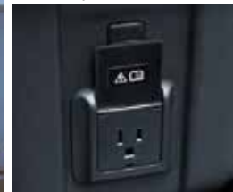
車内に設けられた100V AC電源。
