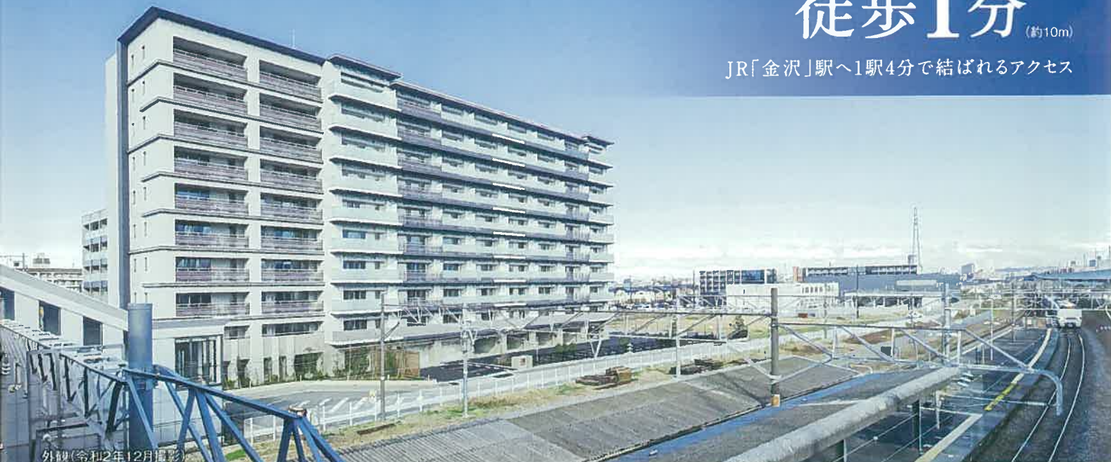
外観(令和2年12月撮影)
